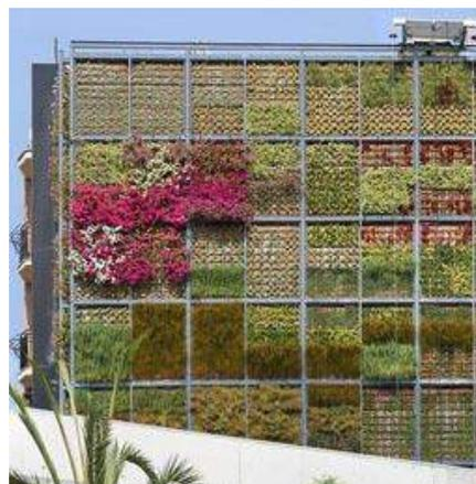
Figura 94: Paredes Verdes, com sustentação de “caixas” metálicas
