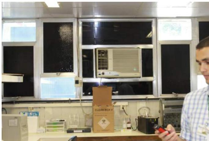
Figura 21 – Equipamento de ar condicionado defasado como fonte de ruído.
