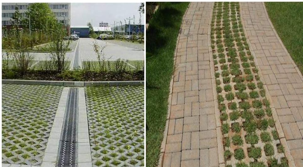
Figura 63 – Exemplos de aplicação dos pavimentos permeáveis. Fonte: [www.ecodebate.com.br](http://www.ecodebate.com.br) – acesso em 08-03-2013.
