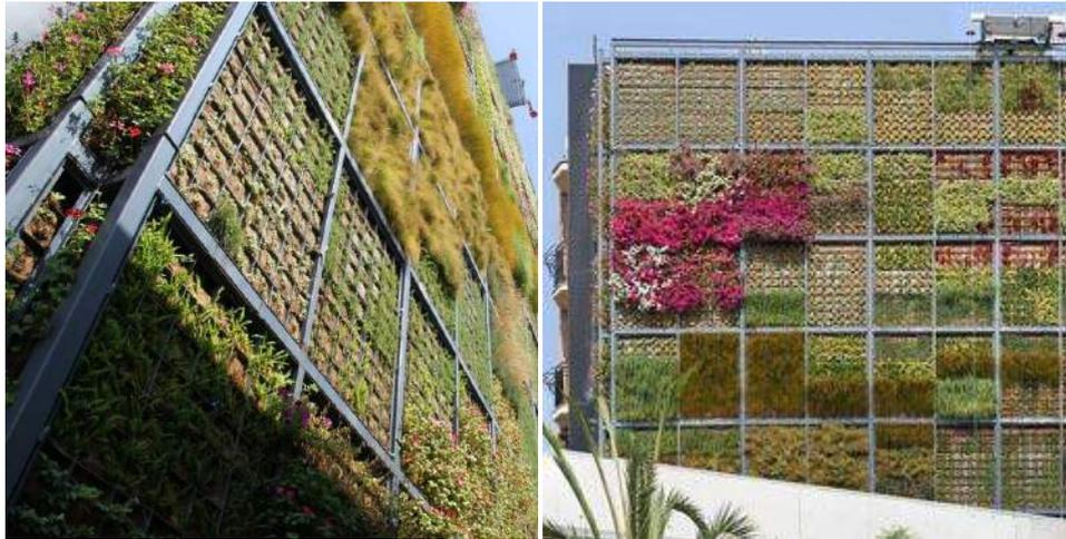
Figura 74: Paredes Verdes, com sustentação de “caixas” metálicas. Fonte:
