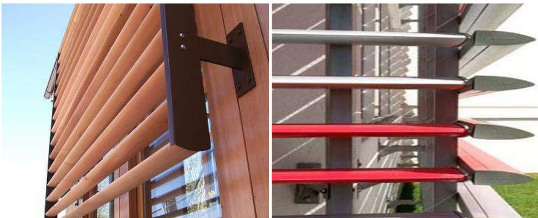
Figura 66 – Exemplo de utilização de dispositivos de proteção solar (brises). Fonte: [blog.gerenciaconstrutora.com.br](http://blog.gerenciaconstrutora.com.br) – acesso em 08-03-2013.
