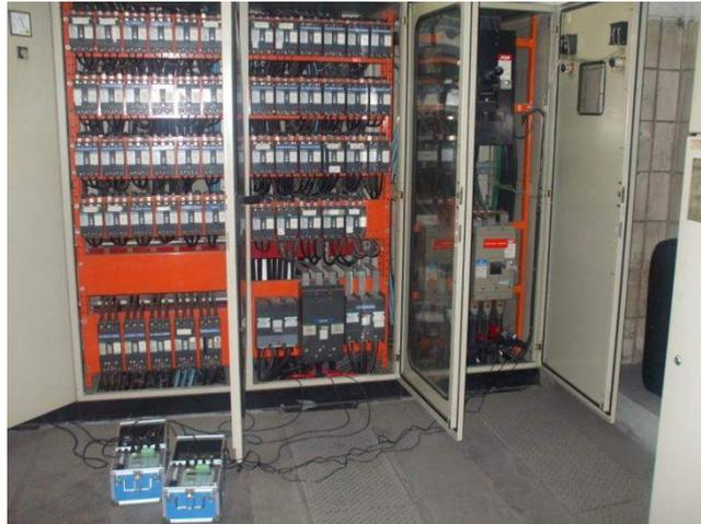
Figura 32 - Medição de um barramento do sistema elétrico do Hemocentro de Fortaleza.
